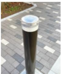
進入を阻止したりする目的で設置される、地面から突き出した杭)が並びます。これは昼間に太陽光を充電し、日没後自動的に発光する仕組みとなっています。このライトによって歩道と車道を明確に分離することで、花見を今までより安全に楽しめることになりました。白色の点灯した光は、太陽電池を採用しているため、電力供給がストップする災害時にも発光します。明かりの全くない夜間の誘導対策にもなります。
